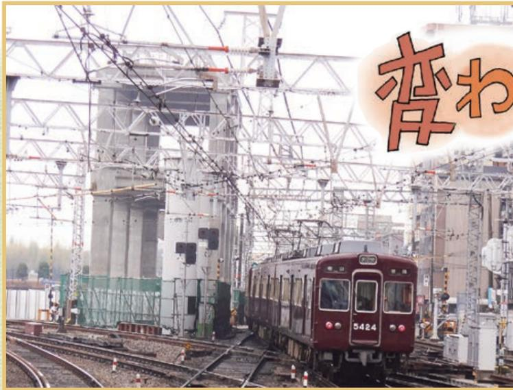
高架工事が進む阪急淡路駅。近鉄線の布施駅のような形状になる。駅舎は4階建てで、2階に改札、3階は上り線(梅田、天六方面)が入り、4階に下り線(河原町、北千里方面)が入る。2018年度(平成29)に高架駅としてリニューアルされる予定。
