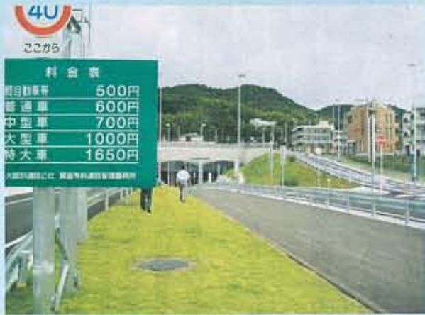
トンネル入口
